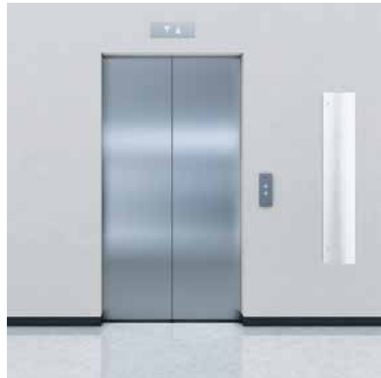
Karmiton KONE ReNova 2-paneelinen keskeltä aukeava ovi rakennusaineisella pielirakenteella ja seinään asennettu huoltopaneeli.
